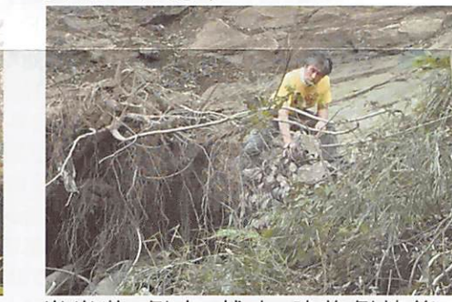
崖崩落・倒木・越水・建物倒壊等 災害復旧支援
