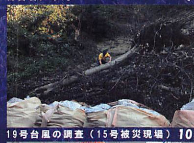
19号台風の調査(15号被災現場) 10
